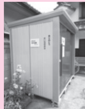
鎌原自治会／防災倉庫
